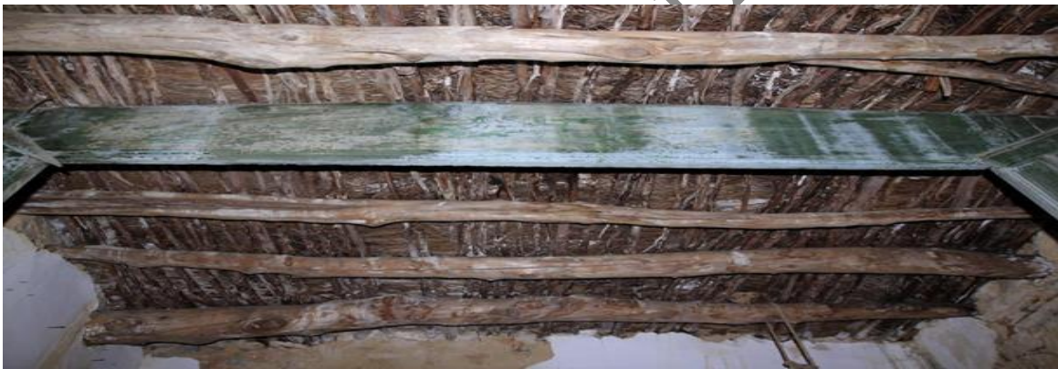
Έτσι ήταν παλιά στην Ηρακλειά η στέγη, κατά σειρά δοκάρια-κλαδιά από φίδες-βούρλα-φύκια-κοκκινόχωμα, όταν η βροχή κράταγε πολλές μέρες έσταζε, μετά στέγνωνε πάλι. (Εικόνα 2)
